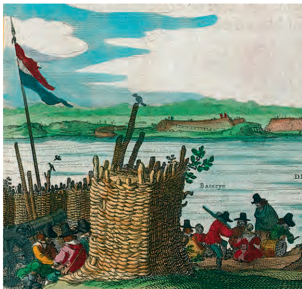
Kogel- en granaatslagen werden opgevangen en gesmoord in met zand gevulde rieten manden, smoorkorven genoemd, die ter bescherming bij geschut opgesteld stonden. (Tekening: Particuliere collectie)
